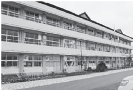
旧浪江東中学校を新築した校舎
